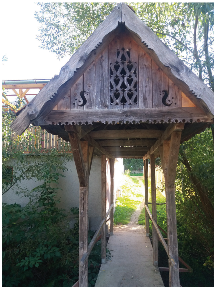
Fedett híd a szentlászlói Bence-patak felett
